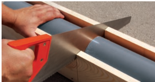
Obrázek 2 Úkos dodatečně zkrácené trubky
