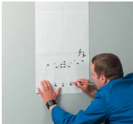
1. Přípravná montáž s montážní šablonou.
