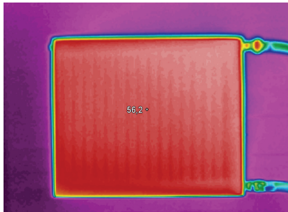
obr.č.12 Plechové otopné těleso konec měření 4 min
