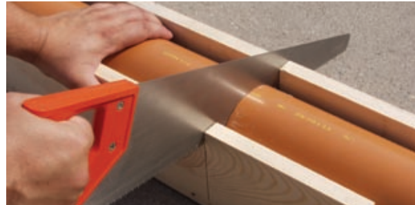
Obrázek 2 Zkracování trubky pilkou
