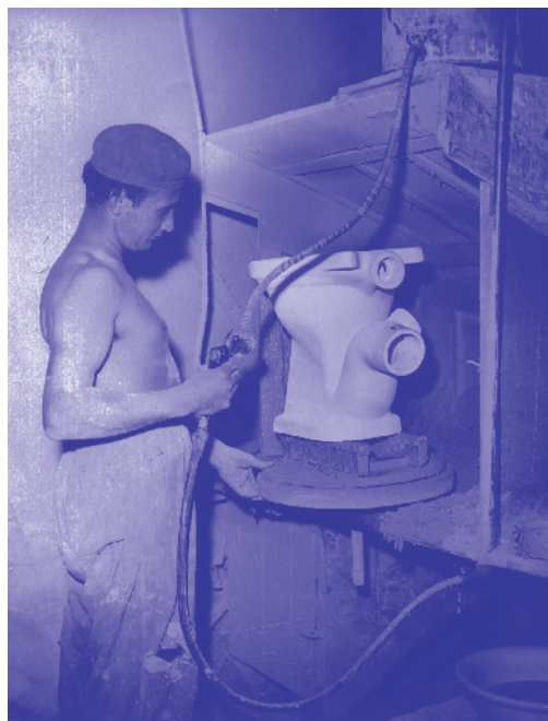
Glazování továrna Znojmo JMM ve Znojmě
