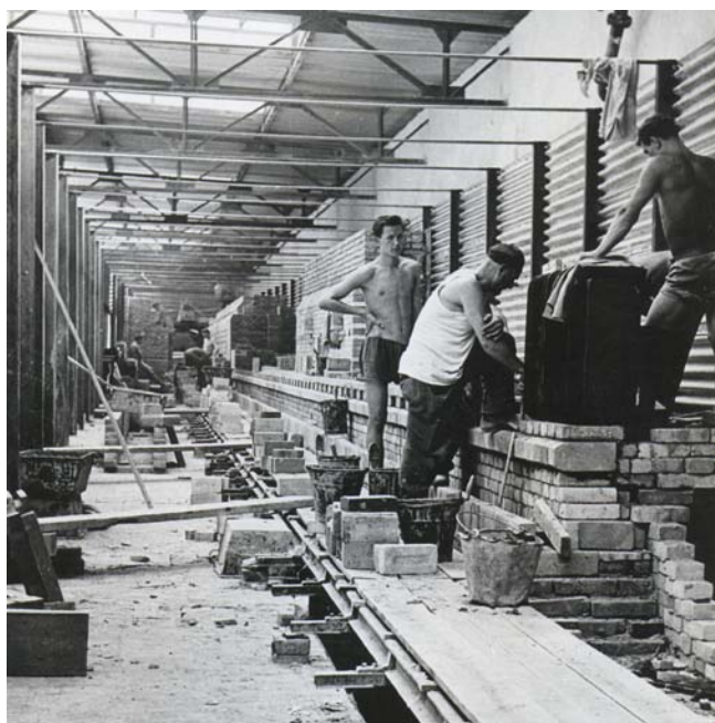
Stavba tunelové pece továrna Znojmo JMM ve Znojmě
